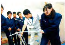
電気工事作業の様子
