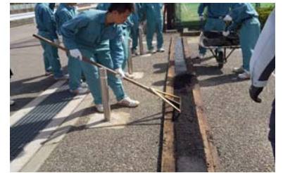
図.3減速帯の施工
