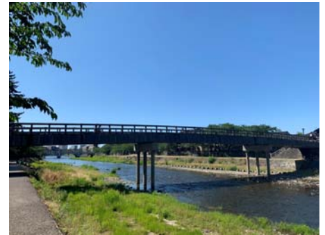
図-1 梅ノ橋全景
